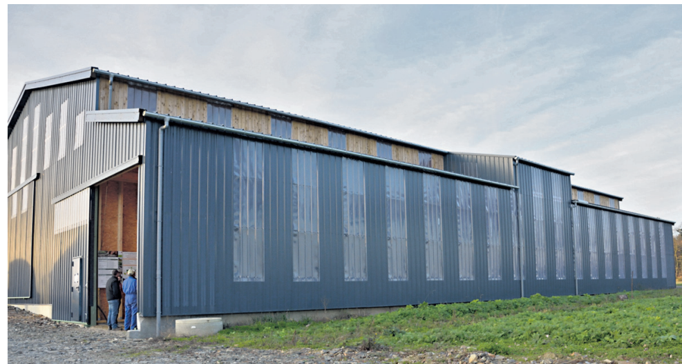
La façade Est avec ses panneaux translucides et OSB noirs récupère la chaleur tôt le matin et se ferme automatiquement vers 15 heures.
