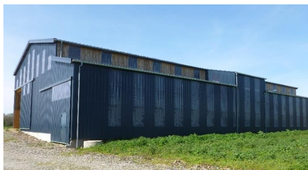
Le capteur solaire, en plus de couvrir le toit, est également intégré sur la façade Est du séchoir
